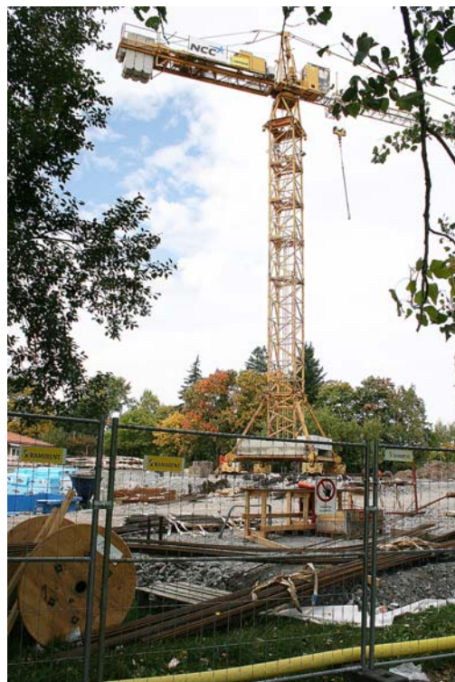
Bild 3 Tillbyggnad av vårdhemmet Korallen
